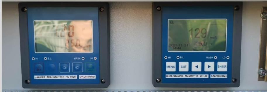
排水在线微型水质站- pH 在线分析仪、悬浮物在线分析仪
