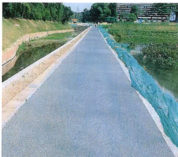
图片 8: 透水混凝土
