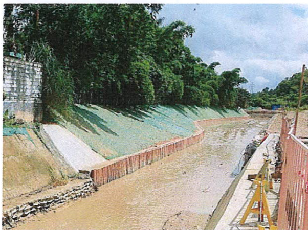
图片 1：石笼护坡
