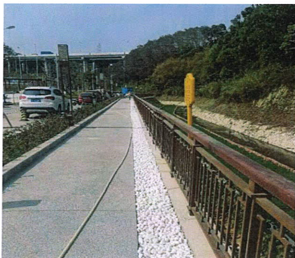
图片 7: 透水混凝土
