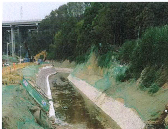
图片 2：石笼护坡
