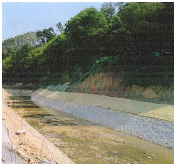
图片 3：抗冲刷生态毯铺设
