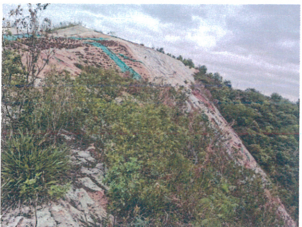
高边坡坡顶红线范围内以及红线外存在水土流失隐患区域（整治中）
