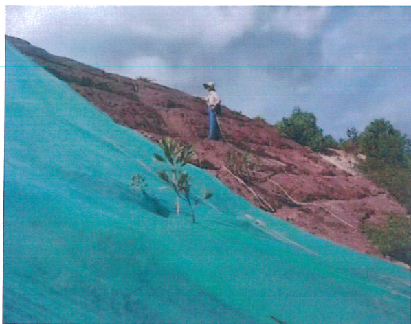
高边坡坡顶红线范围内以及红线外存在水土流失隐患区域（整治中）
