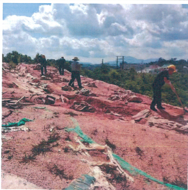
高边坡坡顶红线范围内以及红线外存在水土流失隐患区域（整治中）
