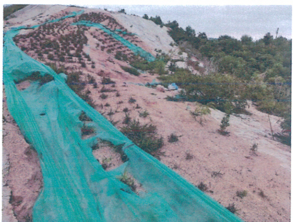
高边坡坡顶红线范围内以及红线外存在水土流失隐患区域（整治中）
