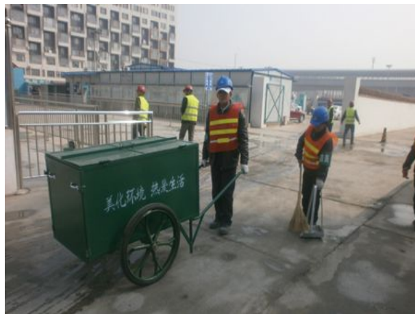
施工场地洒水清扫（2）
