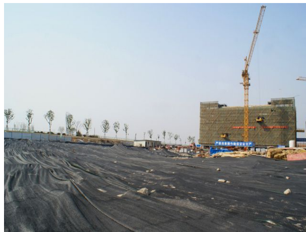
裸露地表防尘网覆盖（2）
