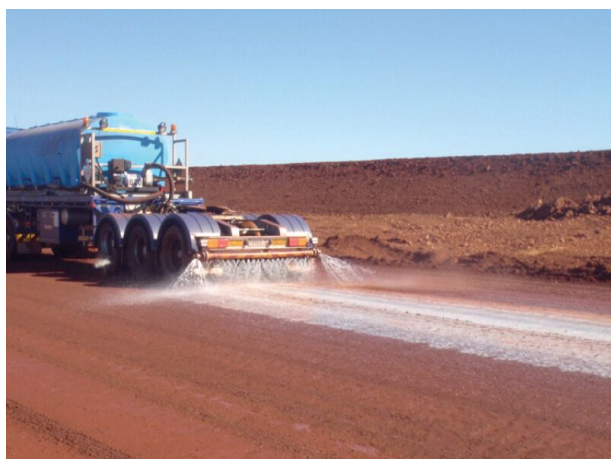
临时运输道路喷洒长效抑尘剂
