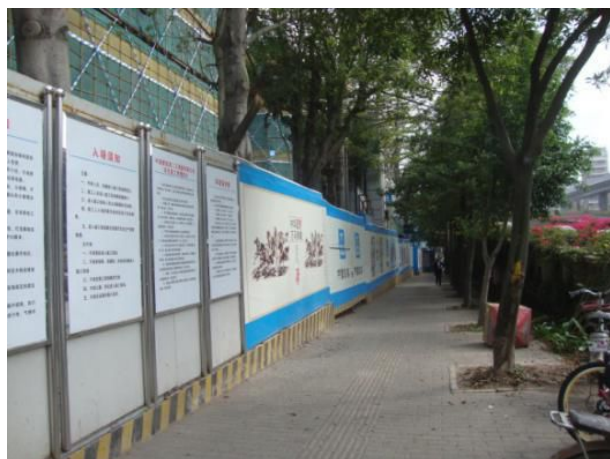
2.5 米高带防溢座施工围挡（2）
