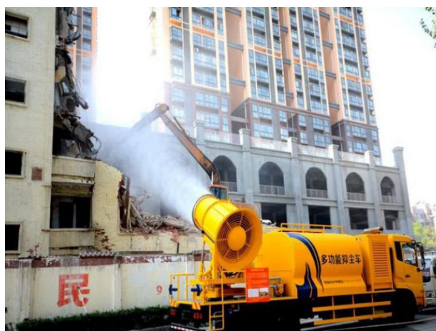
拆除作业中推荐使用喷雾抑尘车
