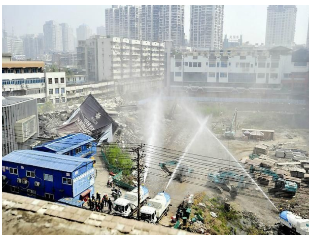
拆除作业中喷淋降尘（3）
