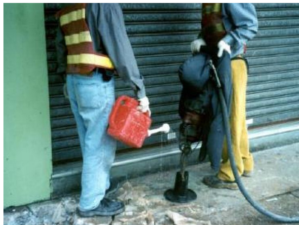
路面破除作业中洒水抑尘
