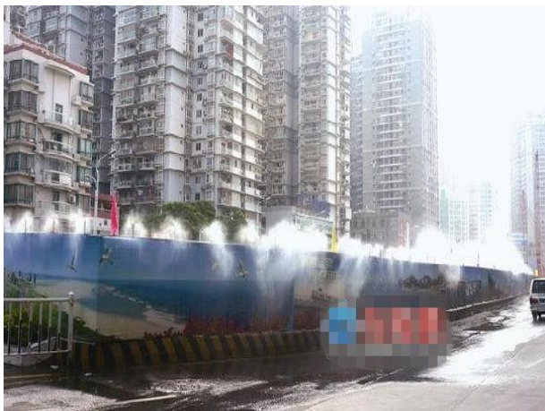
近地面喷淋系统（1）
