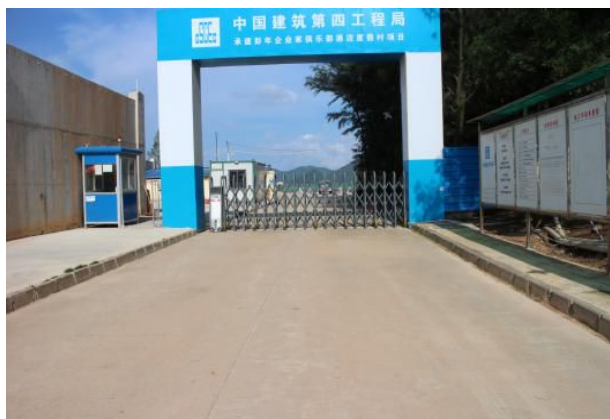
工地出入口地面硬化 (1)
