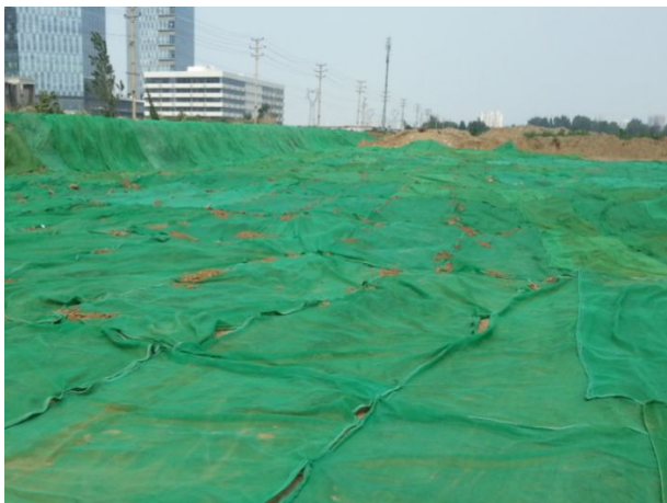
裸露地表防尘网覆盖（1）
