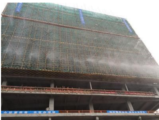
主体结构高空喷淋系统（1）
