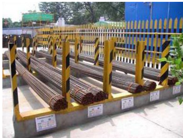
易锈蚀材料架空堆放（2）
