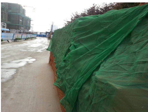
建材分类堆放、防尘网覆盖（1）
