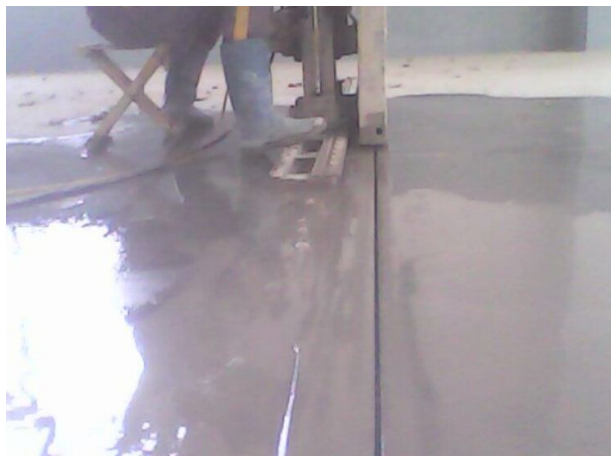
混凝土湿法切割
