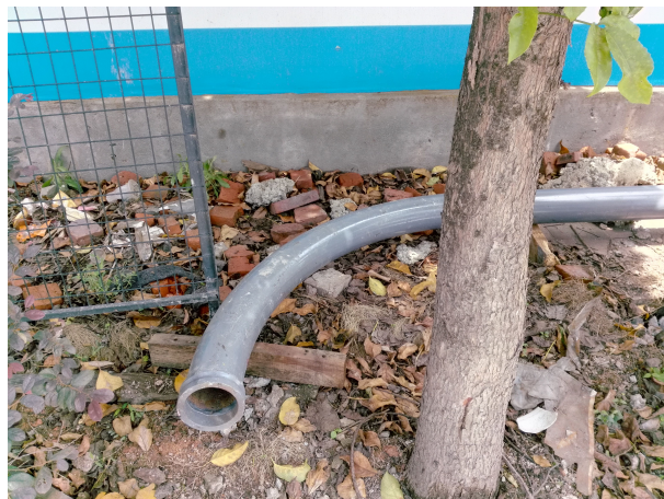
商品混凝土输送管道（2）
