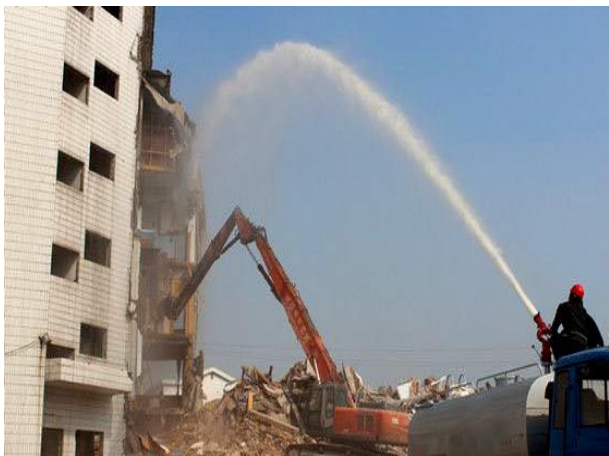
拆除作业中喷淋降尘（1）
