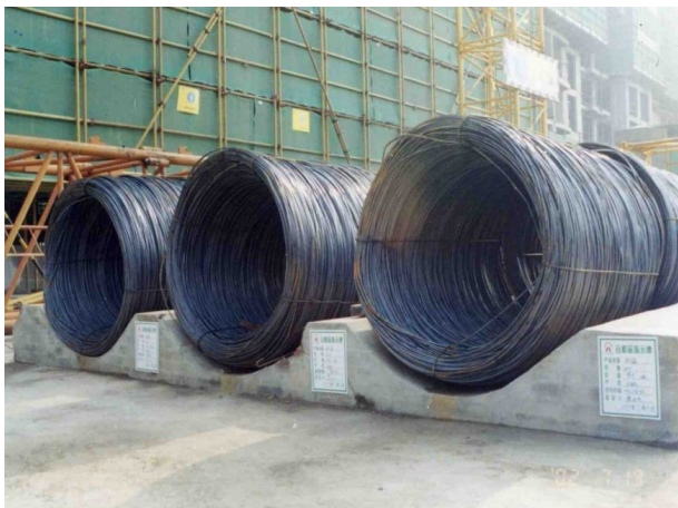
易锈蚀材料架空堆放（1）
