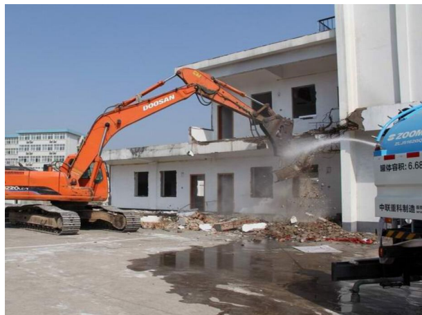
拆除作业中喷淋降尘（2）
