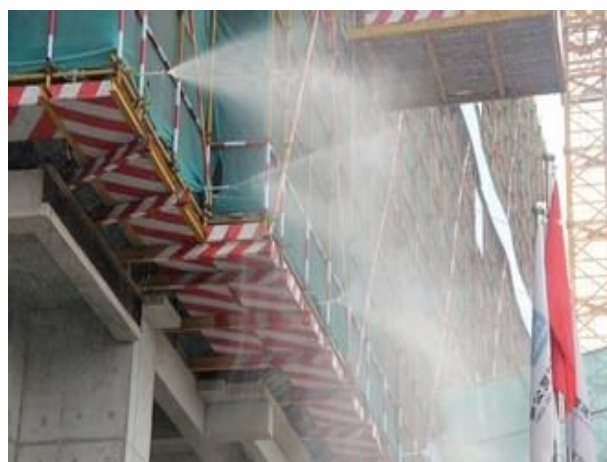
主体结构高空喷淋系统（2）
