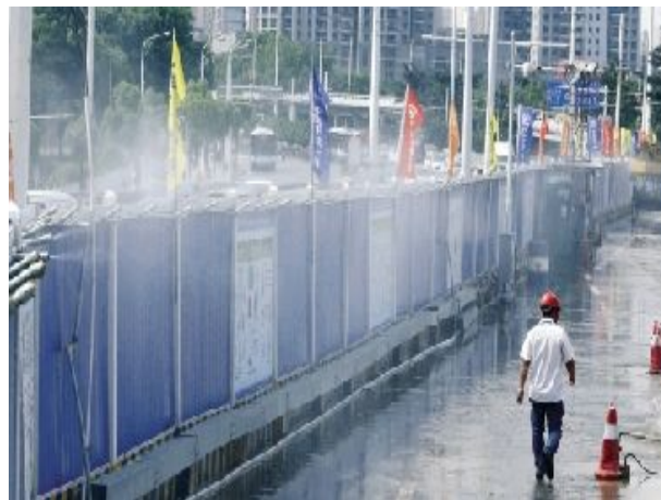
近地面喷淋系统（2）
