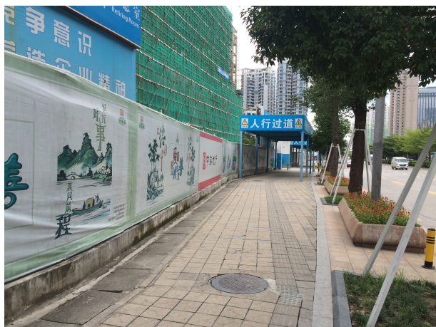
2.5 米高带防溢座施工围挡（1）
