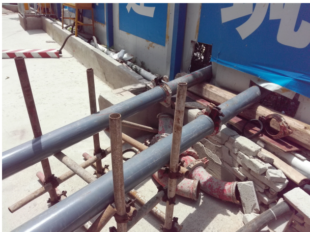
商品混凝土输送管道（1）
