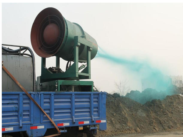
临时性土堆喷洒抑尘剂
