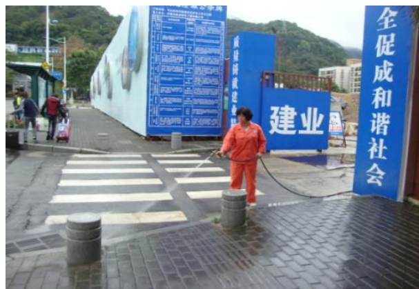
工地出入口地面硬化 (2)
