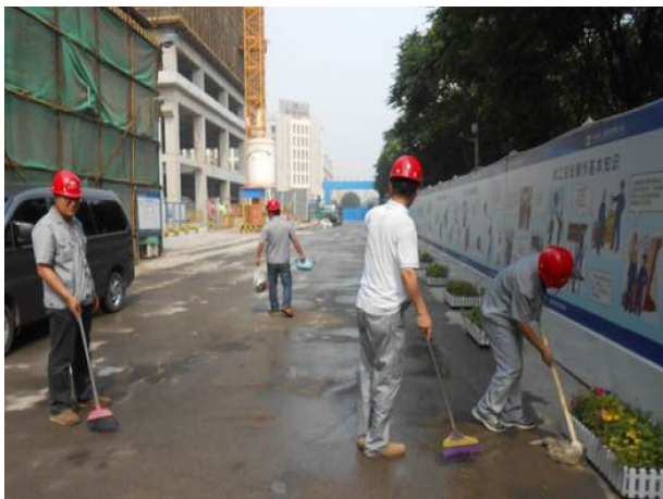
施工场地洒水清扫（1）
