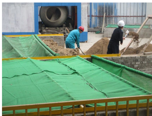
建材分类堆放、防尘网覆盖（2）
