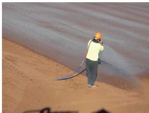
非运输裸露地表喷洒抑尘剂（1）
