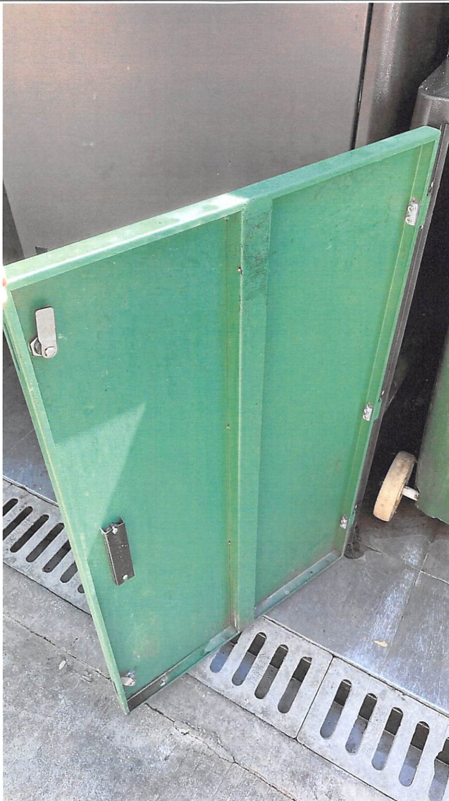
厨余垃圾收集容器门设置 3 个铰链、加强结构
