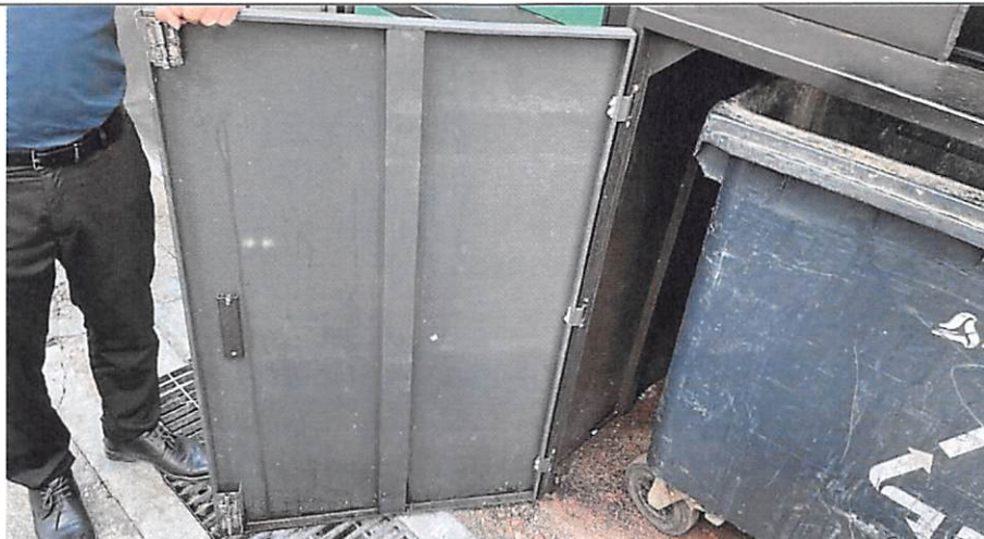
其他垃圾收集容器门设置 3 个铰链、加强结构
