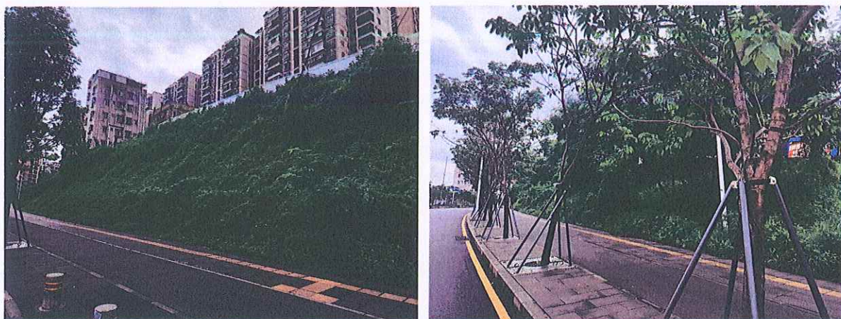
图 5.2-1 道路及边坡绿化
