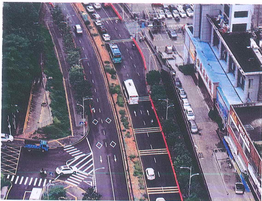
道路中央绿化带（由龙岗区城市管理和综合执法局正在实施，非本项目施工内容）
