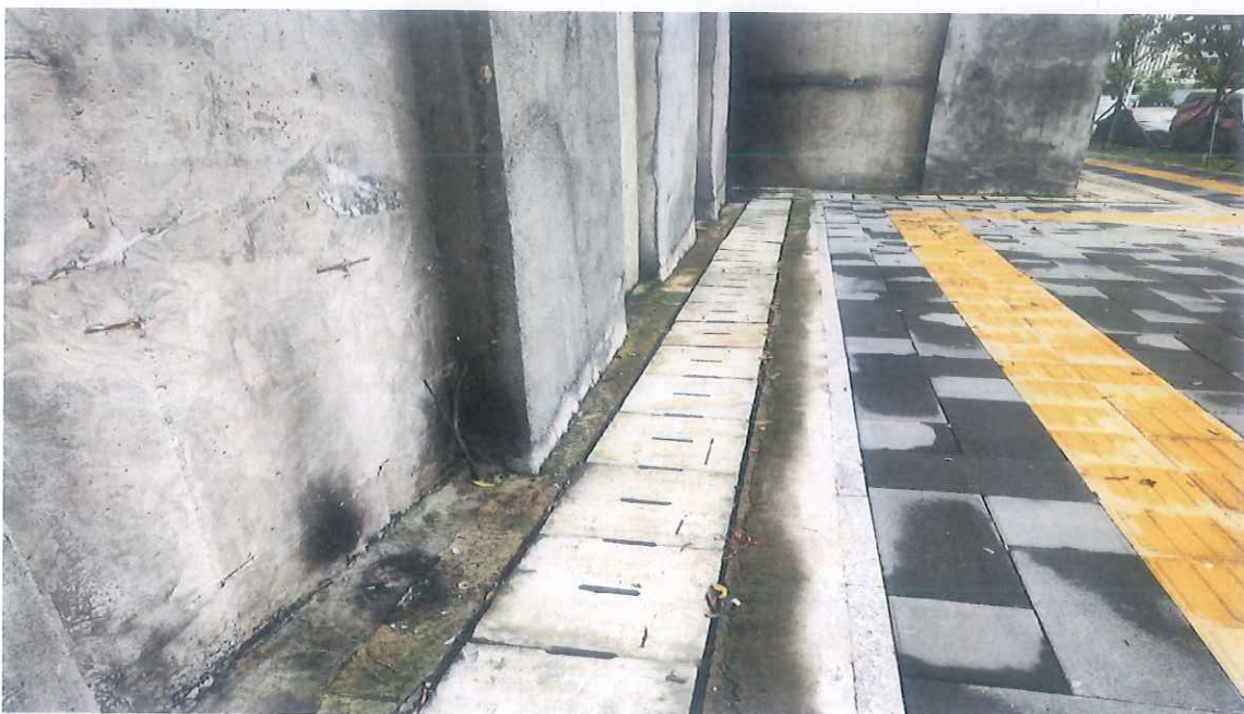
双排桩挡墙底部排水沟
