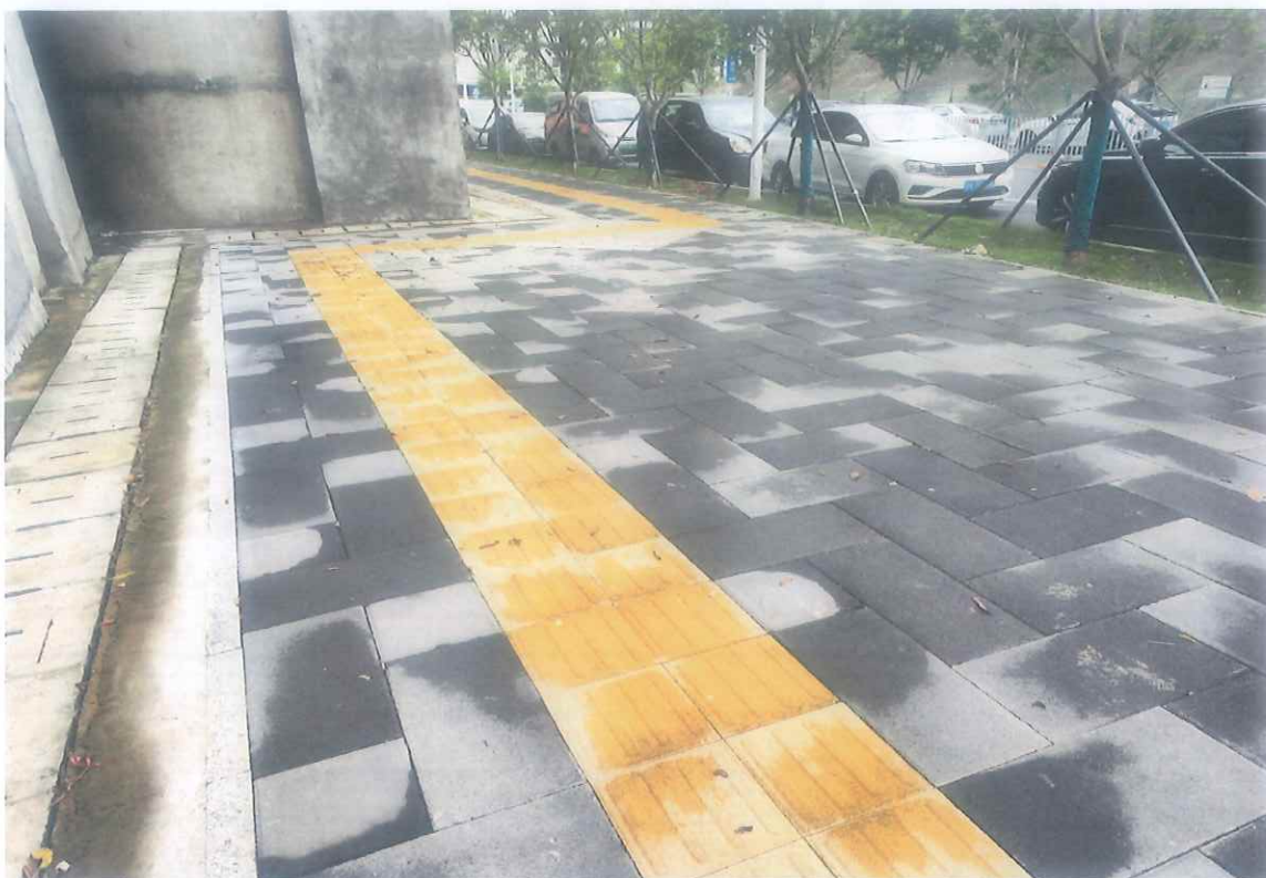
人行道透水铺装
